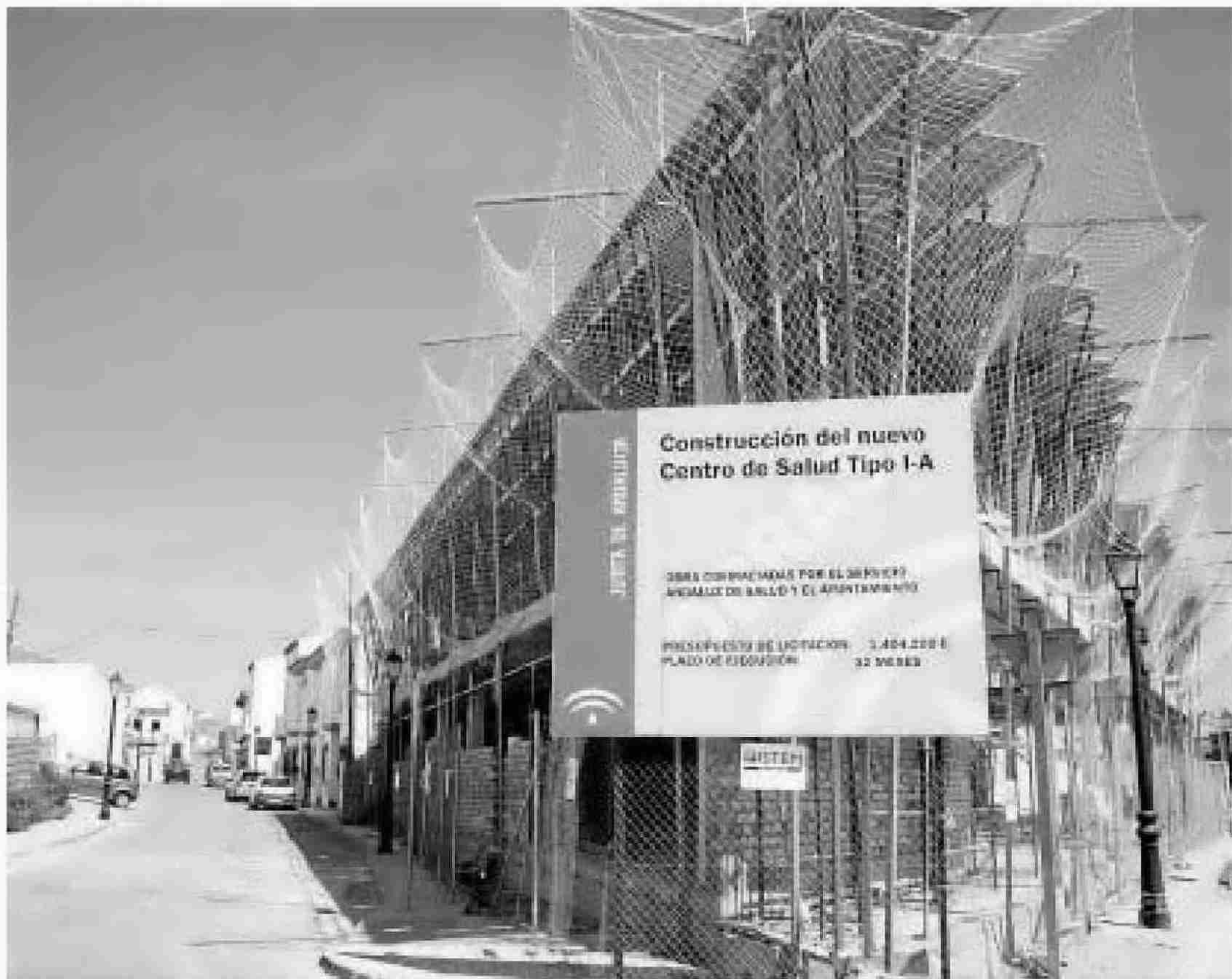
El nuevo centro de salud, actualmente en construcción.
